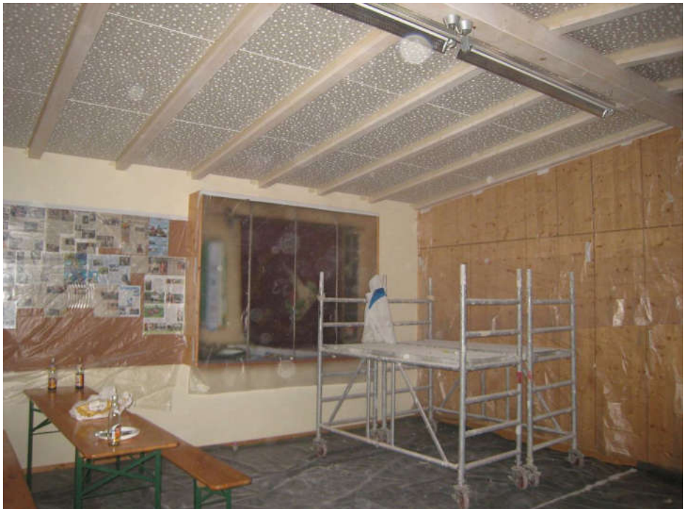
Nach Einbau eines Dachstuhles mit Holzdecke wird diese aus Schallschutzgründen mit einer Akustikdecke versehen.
