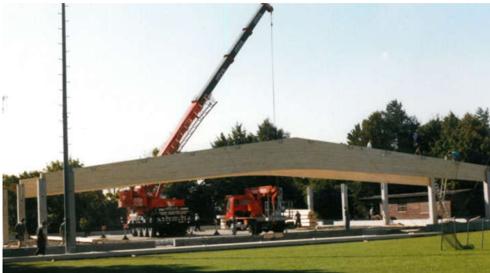
Frühjahr 1999 – endlich ist es nach drei Jahren Entscheidungs-, Planungs- und Genehmigungsphase soweit – es ist Baubeginn, nach Fertigstellung der Betongrundfeste und der Betonsteher hebt ein Schwerlastkran die Leimbinder, die die Halle frei überspannen auf die Betonsteher.
